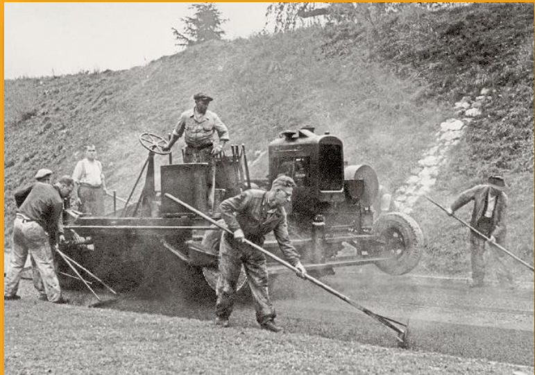
1949; Der erste Belagsfertiger der Firma (Marke: Adnun)
