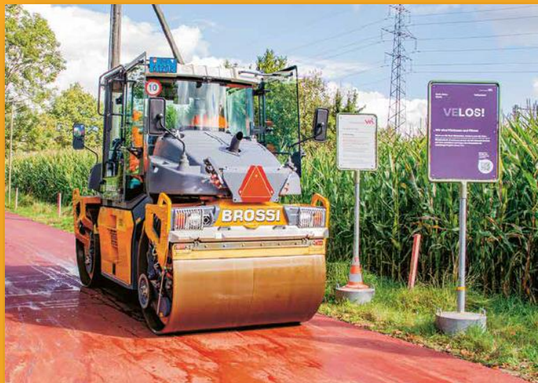
2021; Einbau von Farbasphalt Radweg Winterthur Töss
