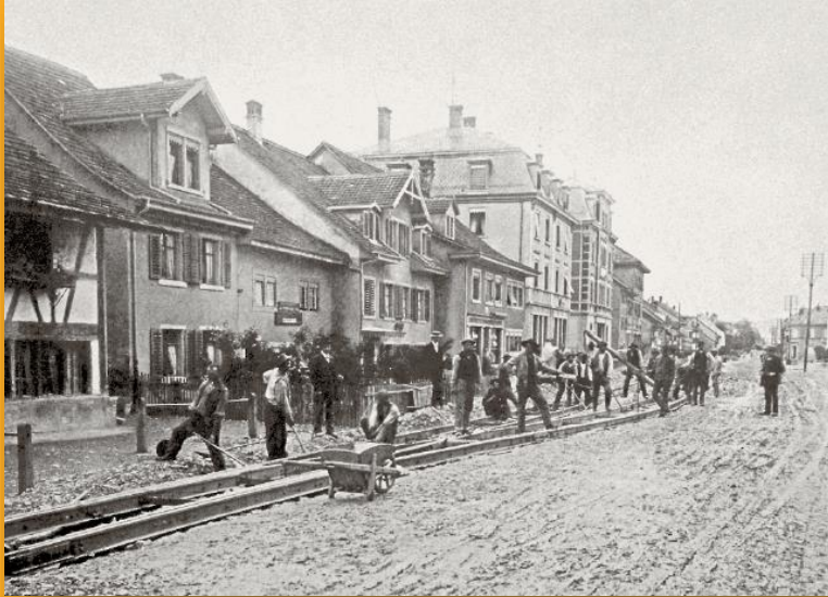
1898; Brossi-Arbeiter verlegen Tramgleise an der Zürcherstrasse in Töss
