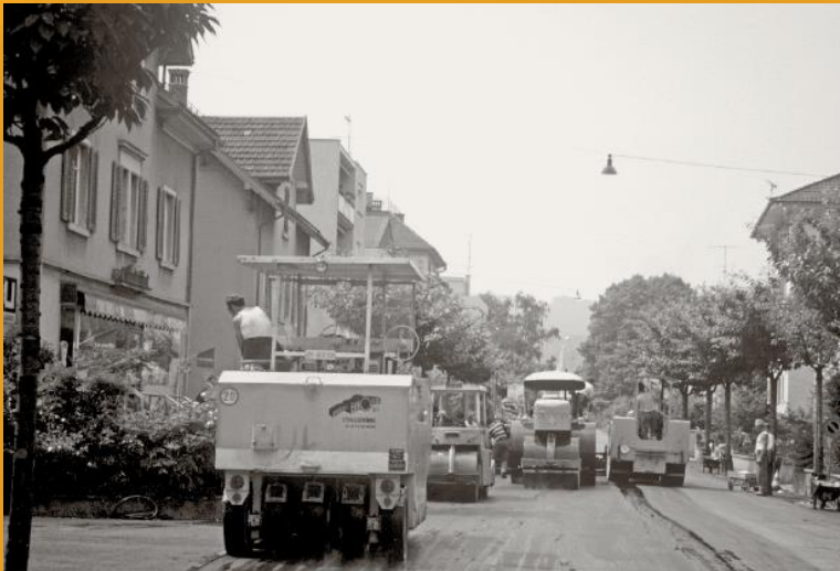
1970; Belagsarbeiten an der Agnesstrasse in Winterthur
